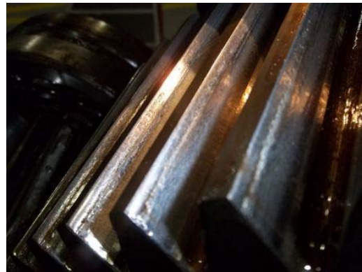
Detalle del estado de la superficie de los dientes de la rueda
